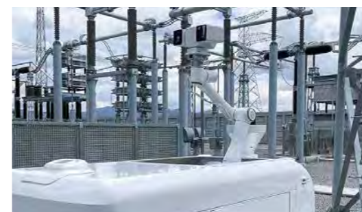
IR-Inspektion in elektrischen Kraftwerken
